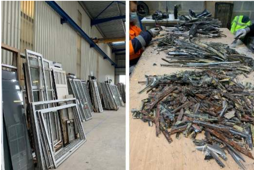
Reprise des anciennes menuiseries et démantèlement par chantier de réinsertion.
